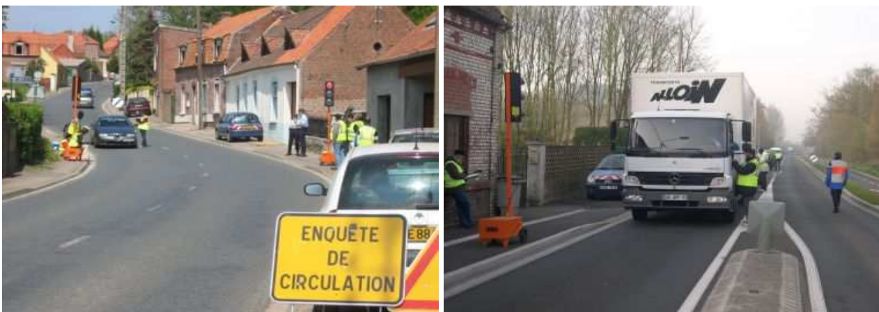
Illustration 02: Arrêt des véhicules sur voie de circulation avec feux de chantier (source : CETE Nord Picardie)
